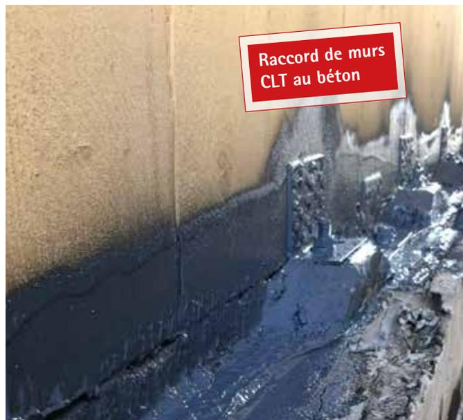
Passage étanche à l'air entre des éléments CLT et des dalles béton par exemple, y compris dans des configurations géométriques complexes (par exemple équerres). Pour cela, le CLT (ou au moins la couche en liaison avec la pulvérisation) doit être étanche à l'air. Les mortiers gonflants peuvent y être simplement intégrés.
