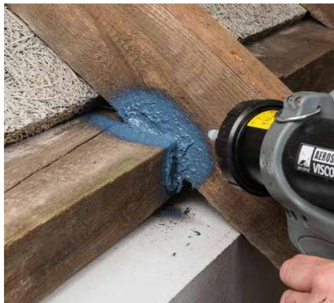
Intégration étanche à l'air facile de percements (par exemple de faux-entrants ou de chevrons lors de la rénovation d'un toit par l'extérieur).
