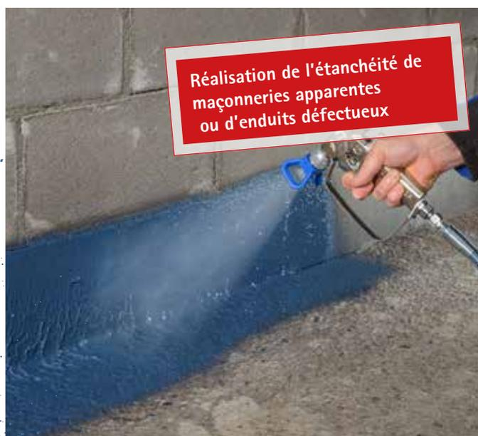
Réalisation de l'étanchéité à l'air de maçonneries apparentes.
