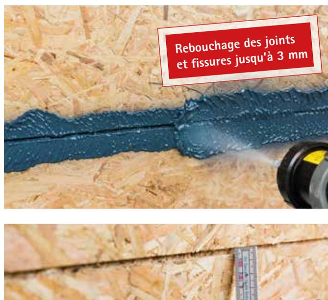
Rebouchage facile de fissures grâce à l'application du film au pulvérisateur ou au pinceau. Pour cela, les défauts dans la couche d'étanchéité sont remplis et recouverts avec AEROSANA VISCONN.
