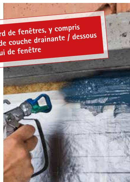
Raccord de fenêtres, y compris seconde couche drainante / dessous d'appui de fenêtre
