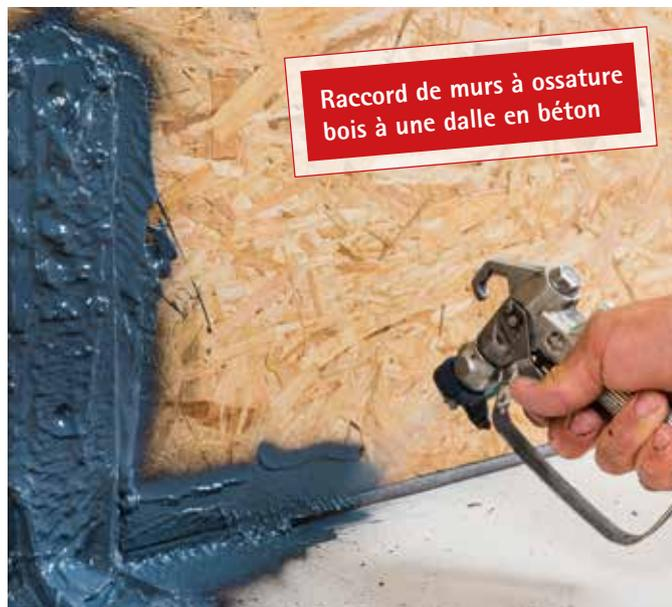
Passage étanche à l'air entre panneaux dérivés du bois (dont OSB) et par exemple une dalle béton. Les mortiers gonflants peuvent y être simplement intégrés. Pulvérisation facile de configurations géométriques complexes (par exemple équerres de fixation). Durabilité contrôlée et certifiée, en accord avec la norme DIN EN 13984.
